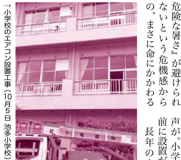
→小学校のエアコン設置工事(10月5日池多小学校)
