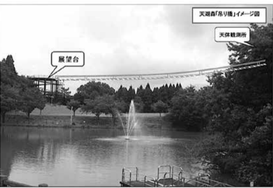
「つり橋」のイメージ図 3月議会の議案説明資料より(富山市作成)
