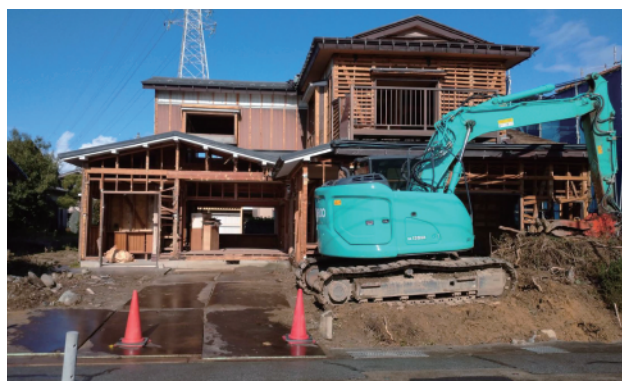
公費解体中の被災住宅（東運町）
